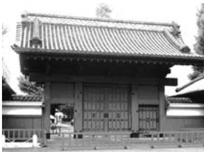
文政10年（1827）前田齋泰に嫁いだ11代將軍家斉の息女溶姫のために建てられた朱塗りの御守殿門。現在、重要文化財に指定されている。
