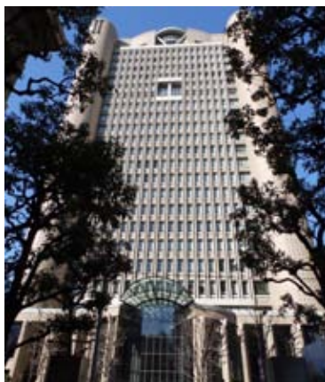
㊦ リバティタワー 平成10年(1998)築。設計/日建設計。明治大学創立120周年記念館として建てられた、地上23階、地下3階の校舎。
